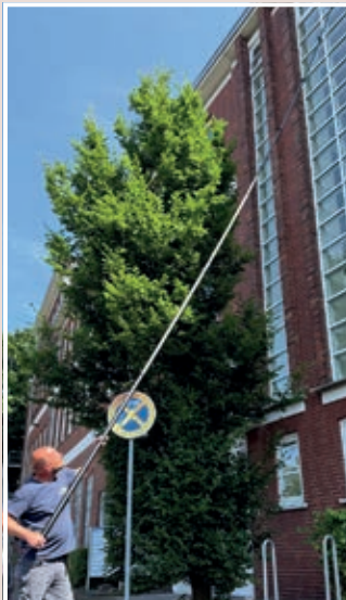
Mit langen Teleskopstangen reinigt AMC auch meterhohe Fassaden.
